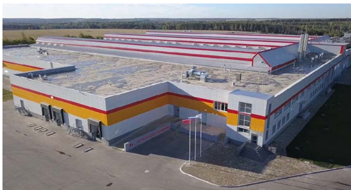
Obr.: Celkový pohled na areál závodu
